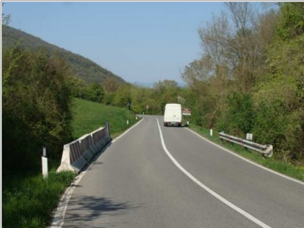
Vista del piano stradale.
