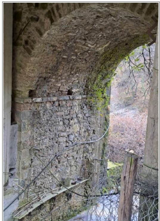
Vista dell'arco in muratura.
