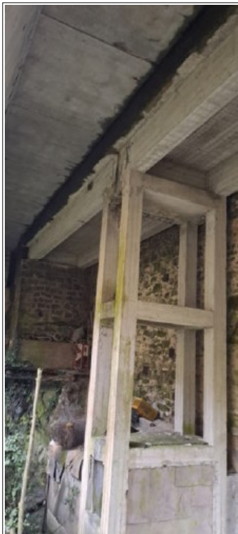
Vista di una struttura di ampliamento dal basso.
