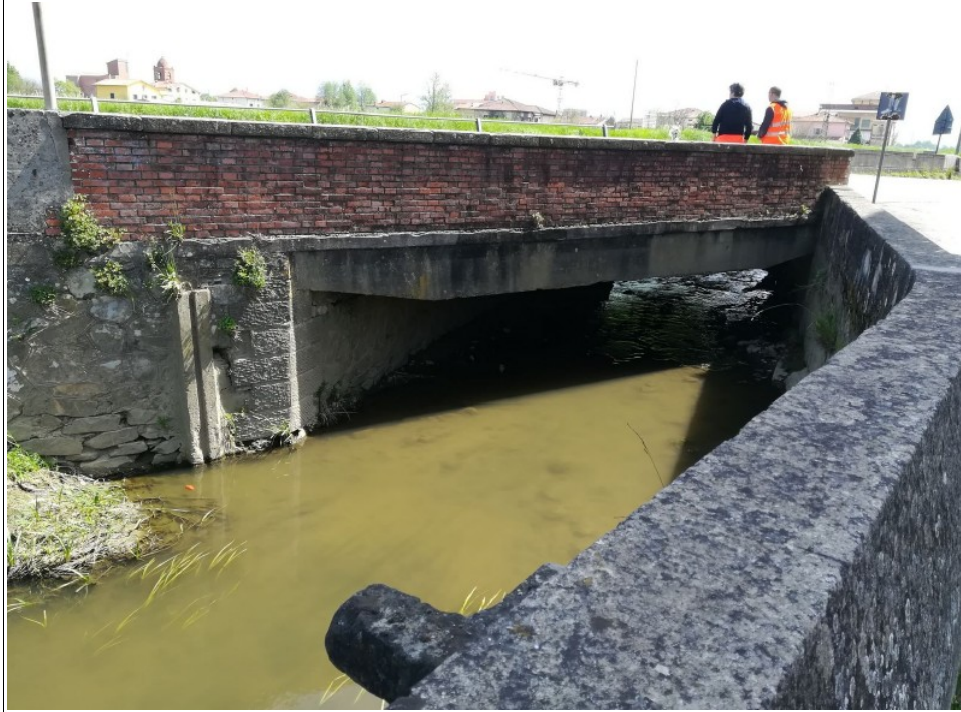
Veduta laterale del ponte.
