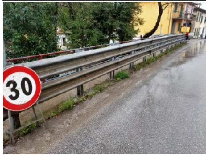
Vista sul piano stradale.
