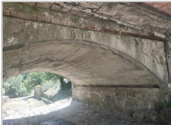
Vista dell'arco all'intradosso.
