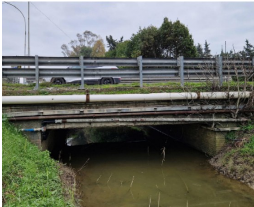
Veduta dell'impalcato e del piano strada.
