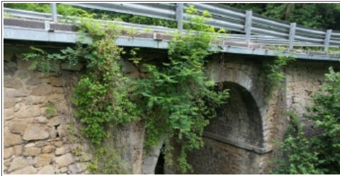
Vista dell'arco e del parapetto sul piano strada.
