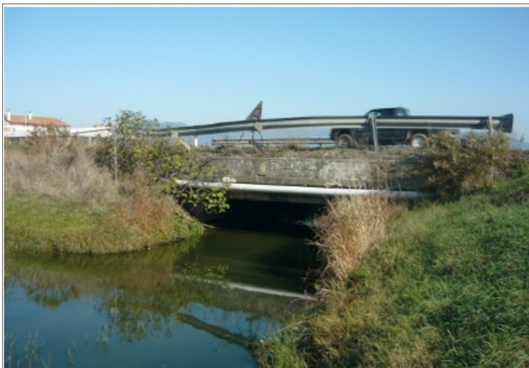
Veduta dell'impalcato e del piano strada.
