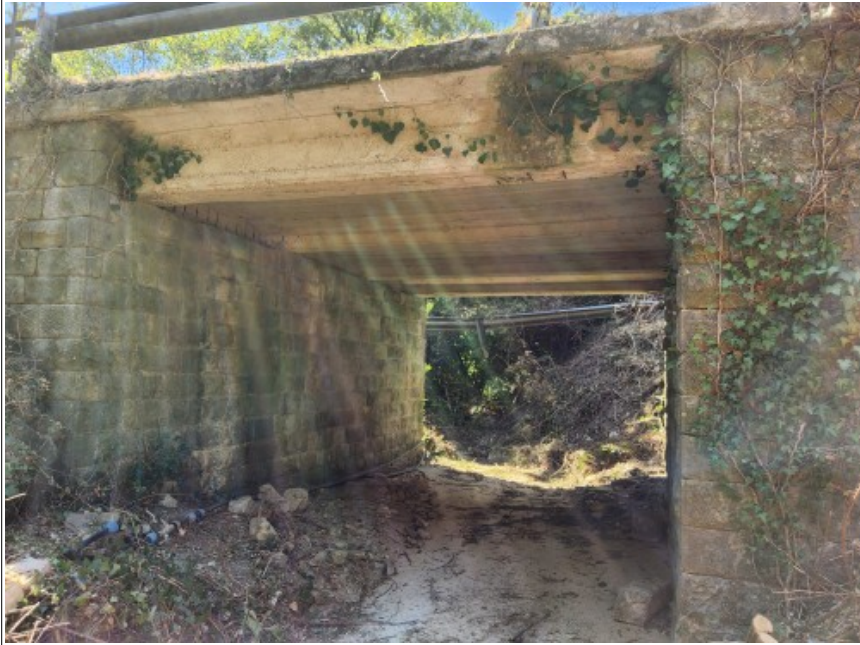
Vista dal basso dell'impalcato e delle spalle.
